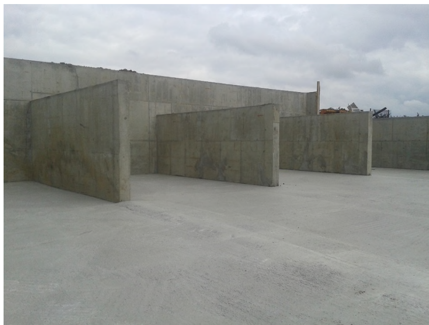
Cases bétonnées sur dalle bétonnée
